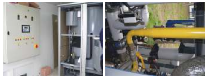
Zakład Gazowniczy (trigeneracja) - RZESZÓW Paliwo: gaz ziemny Moc elektryczna: 116 kW; Moc ciepła: 198 kW; Moc chłodnicza: 122 kW
